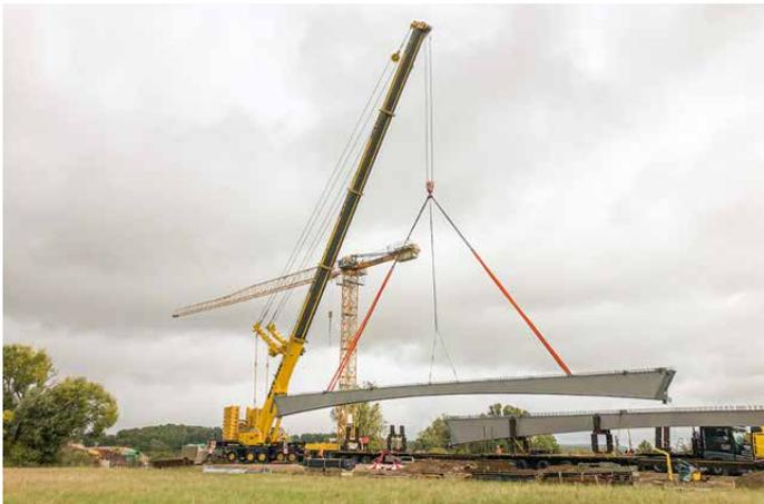
Versetzen von Stahlträgern an der Kreisstraße BA 24 bei Wind
