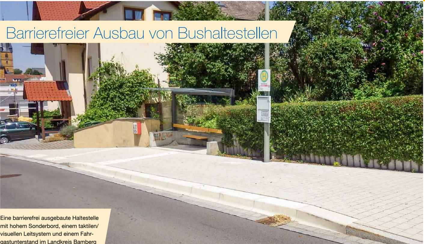
Eine barrierefrei ausgebaute Haltestelle mit hohem Sonderbord, einem taktilen/visuellen Leitsystem und einem Fahrgastunterstand im Landkreis Bamberg
