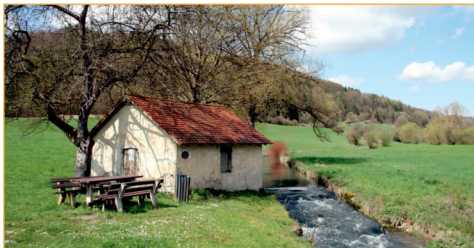
Pumpenhaus an der Leinleiter bei Traindorf
