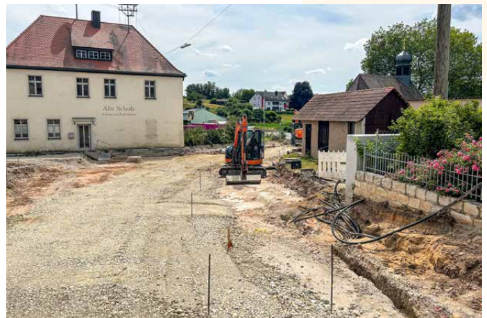
Bild 5: Ausbau Ortsdurchfahrt; Kreisstraße BA 33 in Treppendorf
