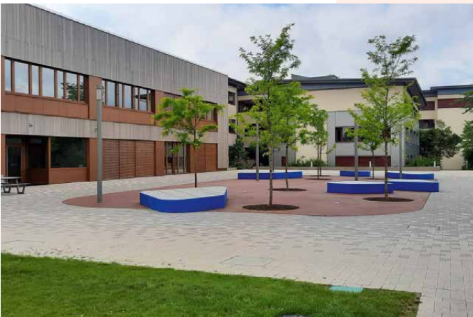
Realschule Hirschaid (Quelle: Realschule Hirschaid)
