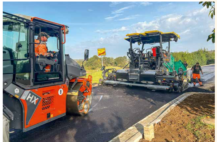
Bild 4: Asphaltbau; Kreisstraße BA 28 in Wattendorf
