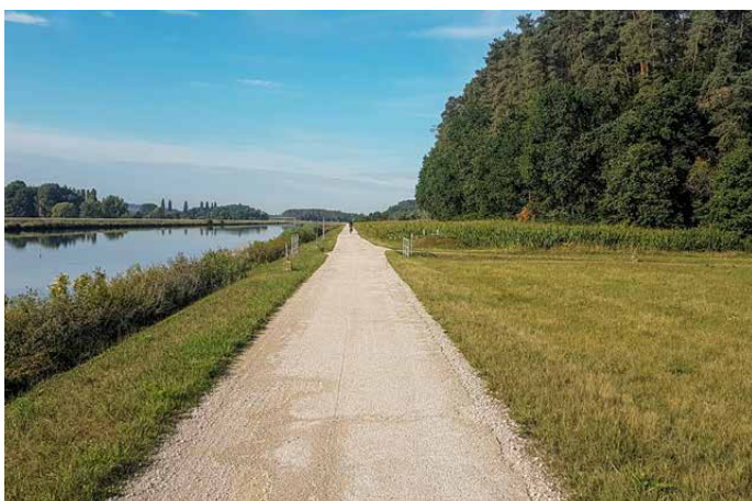
Status Quo Radweg zwischen Hausen und der Stadt Baiersdorf, aufgenommen in Richtung Süden
