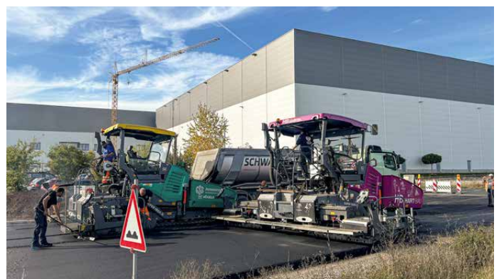
Ausbau Ortsdurchfahrt; Kreisstraße BA 33 in Treppendorf
