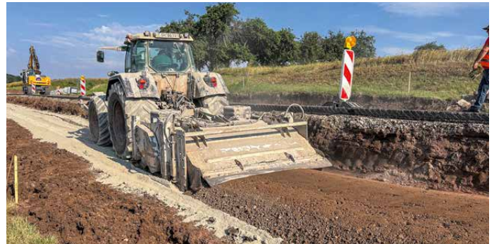
Bodenstabilisierung; Kreisstraße BA 37 bei Priegendorf
