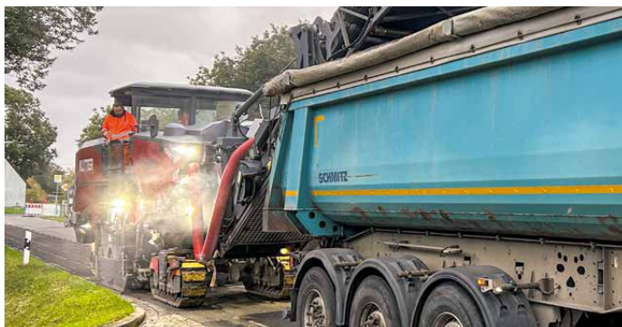
Fräsarbeiten; Kreisstraßen BA 6/10 bei Starkenschwind
