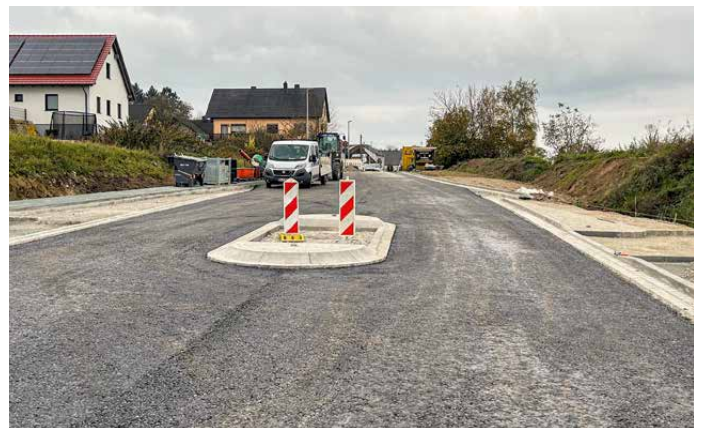
Neubau Geh- und Radweg mit Querungshilfe; Kreisstraße BA 3 bei Seußling
