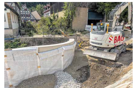
Neubau Ufermauer; Kreisstraße BA 12 in Frankendorf;
