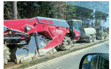
Bodenverbesserung bei Neubau Radweg; Kreisstraße BA 6 bei Hohengüßbach
