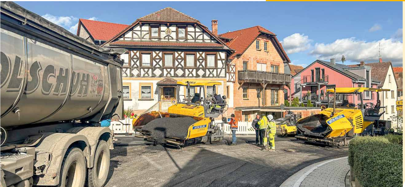
Asphaltarbeiten; Kreisstraße BA 13 in Obernuberg;
