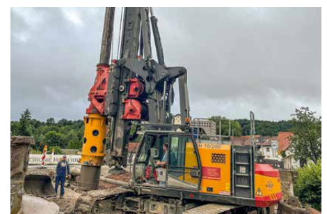
Großbohrgerät; Kreisstraße BA 44 bei Untersteinach
