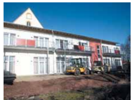
Arbeiten an den Außenanlagen vor dem Erweiterungsbau für das Seniorenzentrum Baunach
