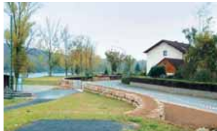
Eine Spundwand mit der sich Ebing unter anderem gegen Hochwasser schützt
