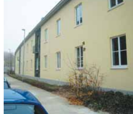
Ansicht der Martin-Luther-Straße, Nov. 2008
