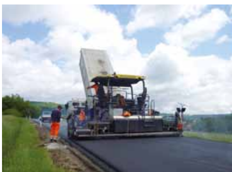
Asphaltfertiger beim Einbau
