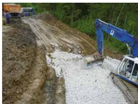
Bagger bei Böschungsrutsch
