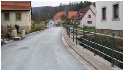
Ortsdurchfahrt Peulendorf (BA 10): Ausbaulänge 600 m veranschlagte Gesamtkosten 855.000 € GVFG-Zuwendung 355.000 €
