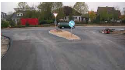
BA 14: Ausbau zwischen der Staatsstraße 2210 und Melkendorf mit Umbau der Einmündung in die Staatsstraße 2210 und Radweg-Lückenschluss
