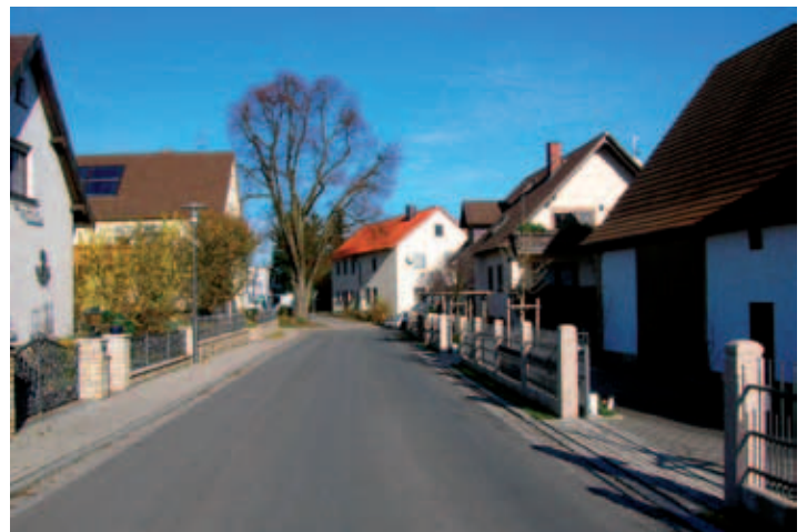
OD Kleinbuchfeld vor und nach dem Ausbau
