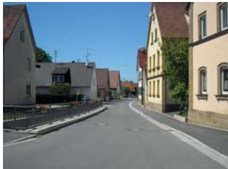
OD Straßgiech nach dem Ausbau mit neuer Verkehrsführung
