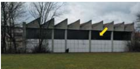
März 2009: Ostfassade der Sporthalle mit großflächiger Gussglasfassade, Sichtbetonflächen, Eternitverkleidung
