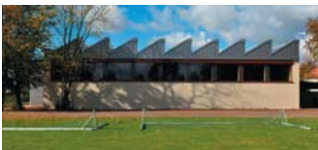
Oktober 2011: Ostfassade der Sporthalle mit neuer Isolierverglasung, Sheddach eingelechzt und gedämmt, Massivbauteile mit Vollwärmeschutz
