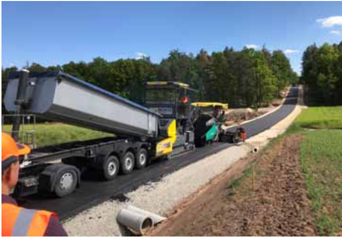
2020 wurde zwischen Treppendorf und Oberköst der Asphalt erneuert.
