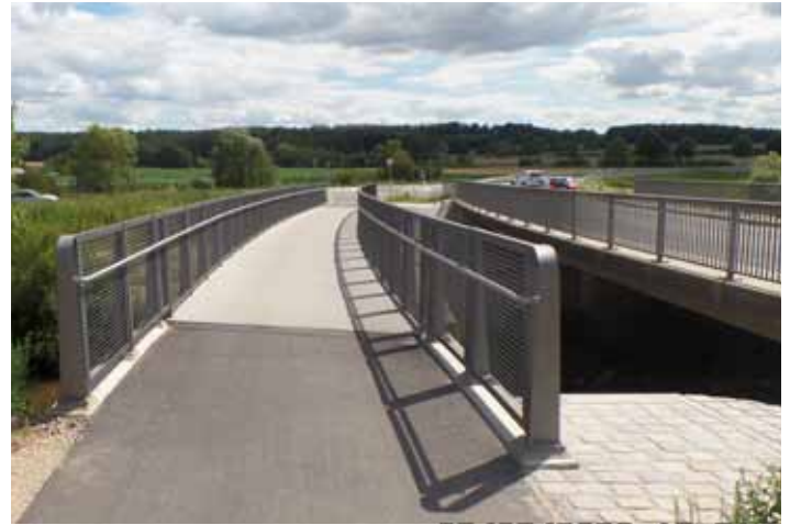
Das Kreisstraßennetz umfasst auch 51 Kilometer straßenbegleitende Radwege. 2020 wurde im Zuge des Ausbaus der Kreisstraße BA 29 zwischen Frensdorf und Reundorf eine Radwegbrücke über die Rauhe Ebrach mit Geh- und Radweg gebaut.
