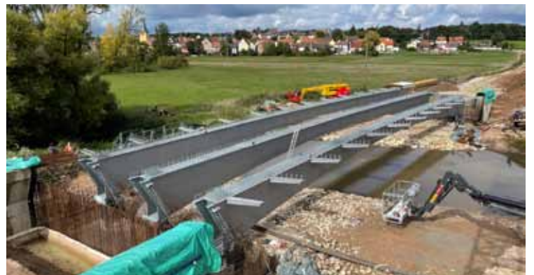
Brückenneubau über die Reiche Ebrach im Zuge der Kreisstraße BA 24
