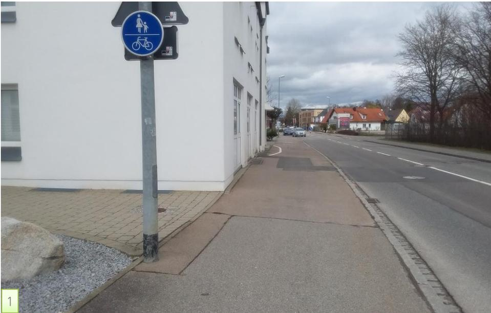
**Bild 1:** Beispiel für einen nicht geeigneten, zu schmalen gemeinsamen Geh- und Zweirichtungsradweg innerorts. Die Breite wird im Bereich des Hauszuganges noch zusätzlich verringert. Nicht nur die geringe Wegebreite ist problematisch, sondern auch die Gefährdung der Radfahrenden aufgrund der sehr unübersichtlichen Grundstücksausfahrten.
